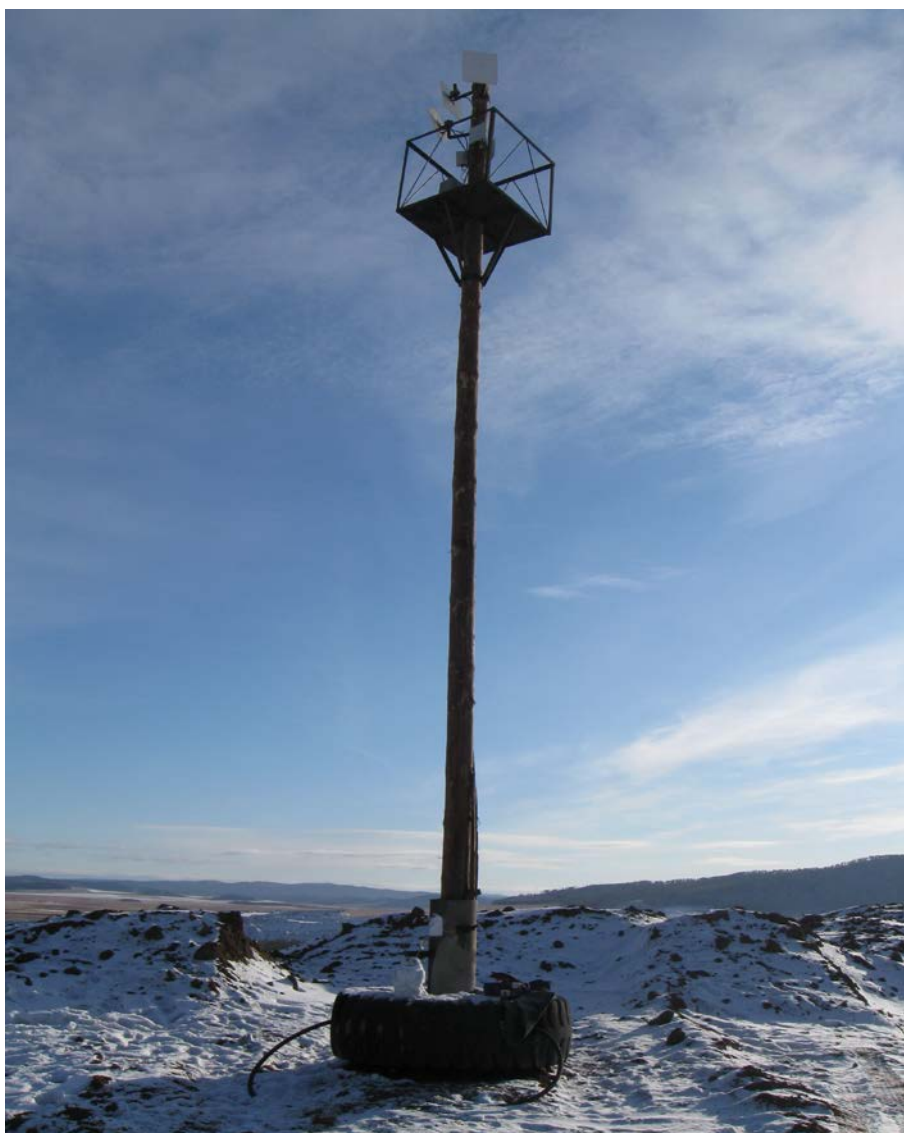
Рис.1. Радиомачта, выполненная на базе деревянной опоры.
