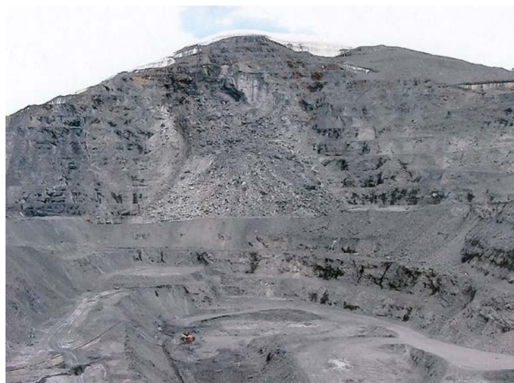
Рис.3. Аварийное обрушение борта карьера на руднике Кумтор.
