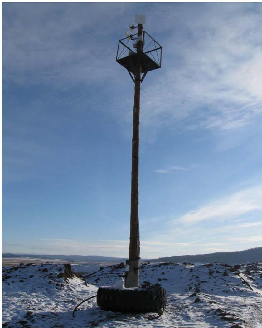
Рис.1. Радиомачта, выполненная на базе деревянной опоры.
