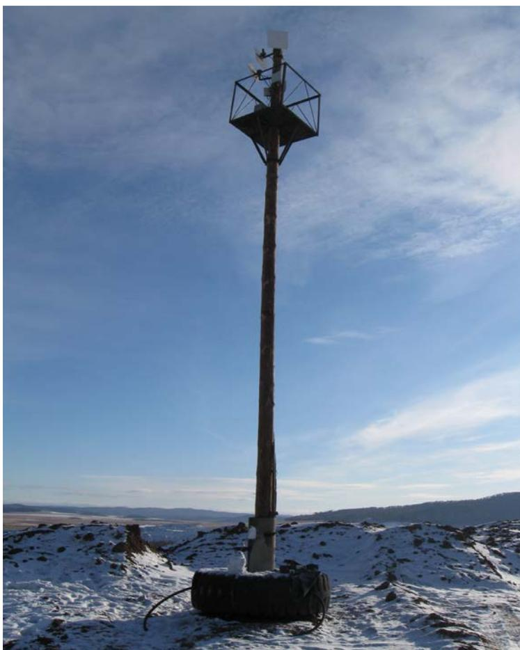
Рис.1. Радиомачта, выполненная на базе деревянной опоры.
